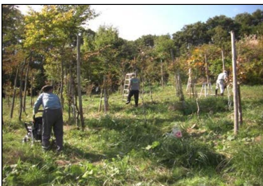
支柱立て作業、現場に到着した小田島さん(10月)
