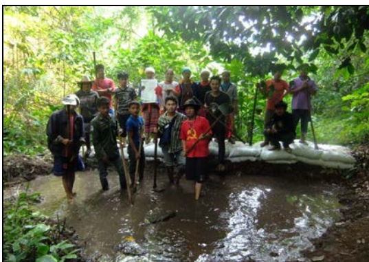
安定した水流を維持するためのチェックダム 土嚢袋に土とセメントを入れ積む
