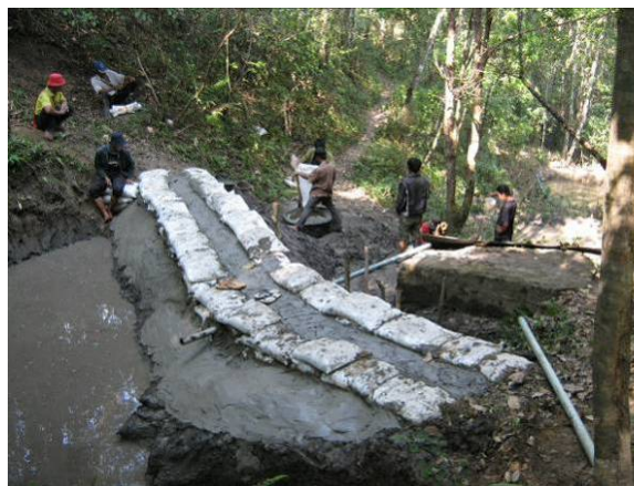
チェックダム設置
