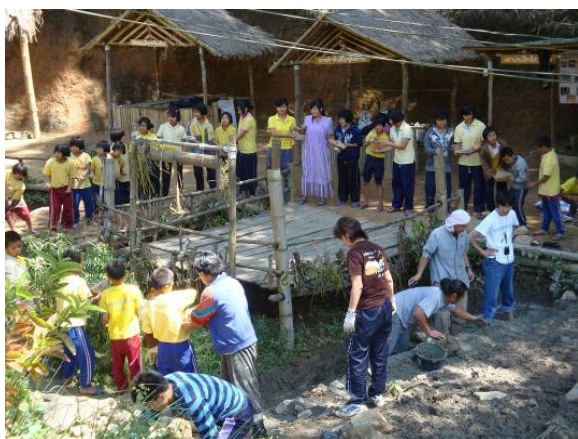
チェックダム設置トレーニング
