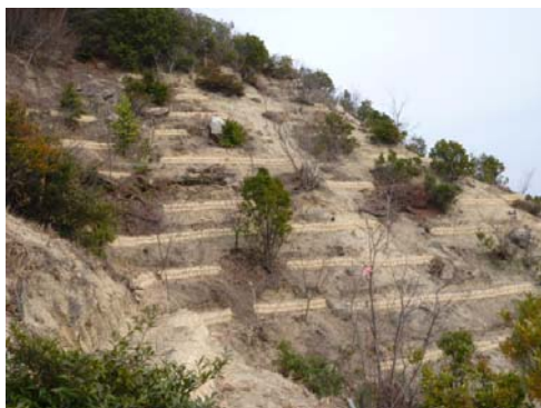
積苗工実施エリア。階段状に積まれたワラが確認できる
