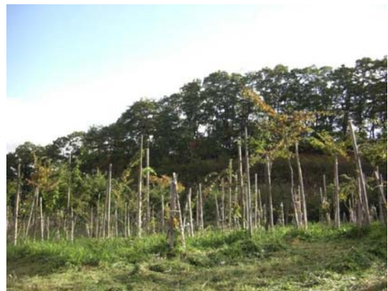
すべてのくい打ちを完了
