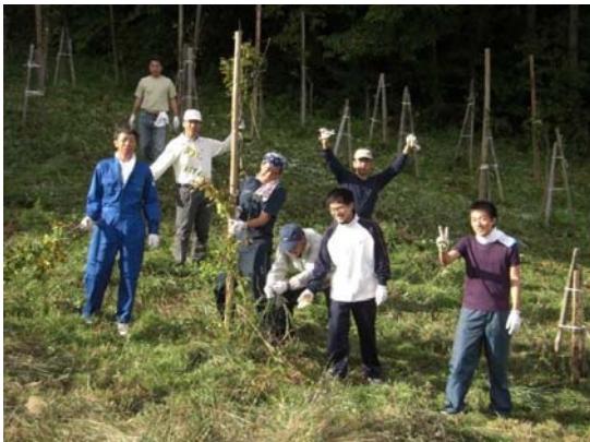
わいわいと杭打ち
